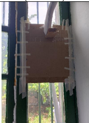
Vedação da janela da sala de procedimentos/laboratório (maio 2025)
